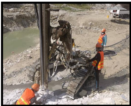
รูปที่ 2-17 เครื่องเจาะแรมี่ที่ตักฝุ่นและพนักงานใส่ชุด safety
